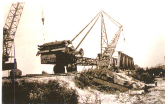
1. Gru ferroviaria «Romaro» (anni Quaranta) mentre sta montando la fiancata di una campata reticolare. Di fianco la gru derrick di servizio analoga a quella di figura 2.
