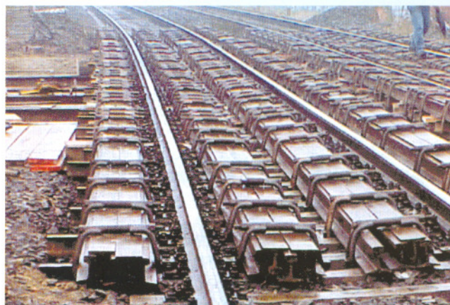
4. Fasci di rotaie disposti in opera.
