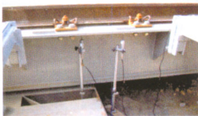
18. Monitoraggio di un ponte Bologna 17 mediante flessimetri.
