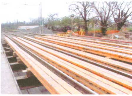
6. Sistema Essen disposto in opera.
