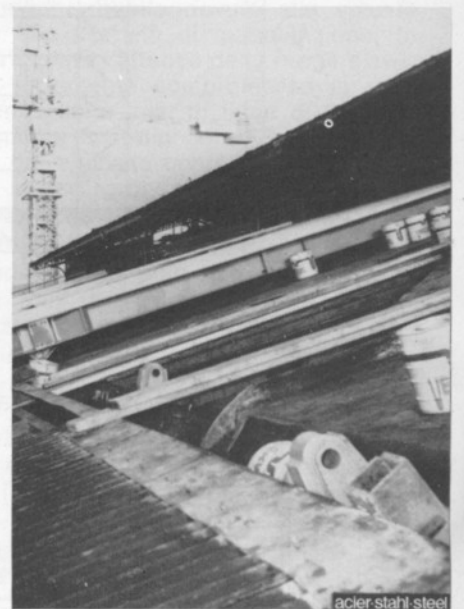
Fig. 16. Nuove travi delle falde della navata centrale; anche queste sono articolate in sommità delle vecchie colonne in ghisa.
