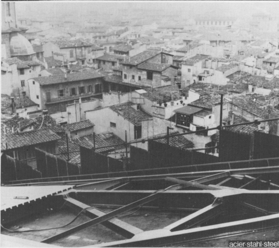
Fig. 17. Posa delle lamiere grecate sulla nuova carpenteria della copertura. La copertura sarà terminata con un lamierino in rame il cui colore non differisce dal colore dei vecchi tetti di Firenze.
