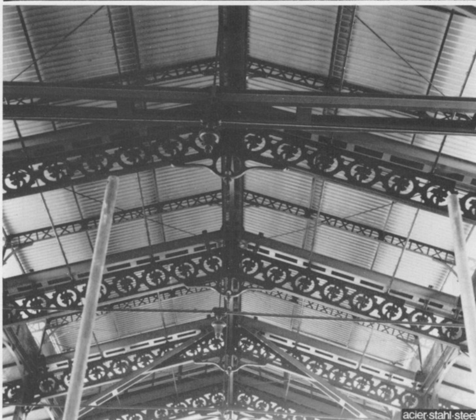
Fig. 11. Particolare del rinforzo delle incavallature della navata centrale.
