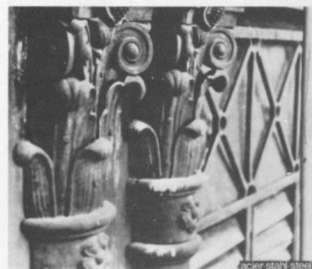
Fig. 5. Capitelli di ghisa in stile corinzio delle colonne di facciata della navata centrale.
