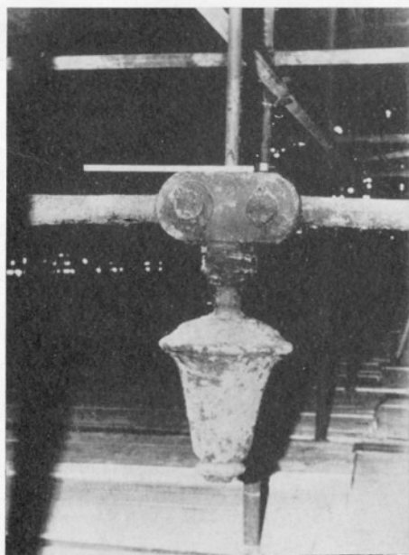
Fig. 10 - Particolare della sospensione del tirante di una incavallatura della navata centrale, con ornamento a fondo di lampada.
