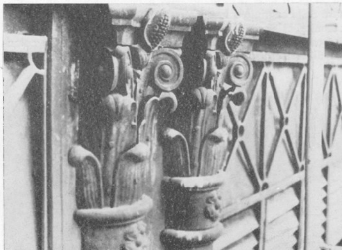
Fig. 9 - Capitelli di ghisa in stile corinzio delle colonne di facciata della navata centrale.
